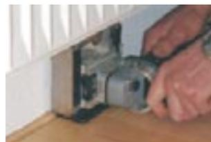
Dehnfugen schneiden unter Heizkörper
