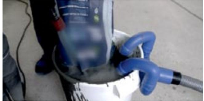
Durch Anschluss eines Staubsaugers werden die gefährlichen, mineralischen Stäube, die beim Anmischen von Spachtelmasse entstehen, auf ein Minimum reduziert.
